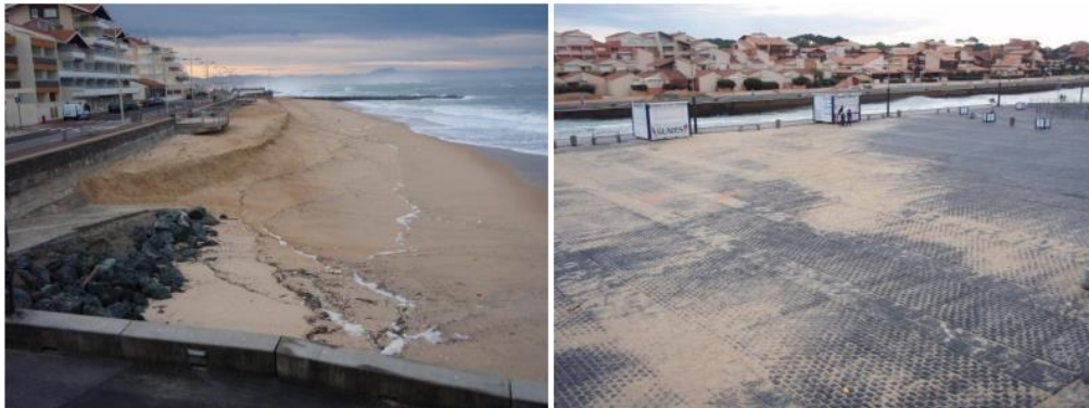
Figure 50 - Gauche : érosion de la Plage centrale ; Droite : submersion et dépôt de sable sur la promenade de la jetée Sud (Capbreton, 08/01/2014, BRGM).
